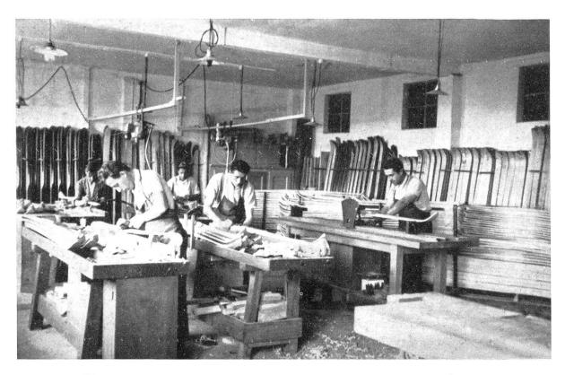
Equilibrage et finissage des skis; pose des arêtes.
