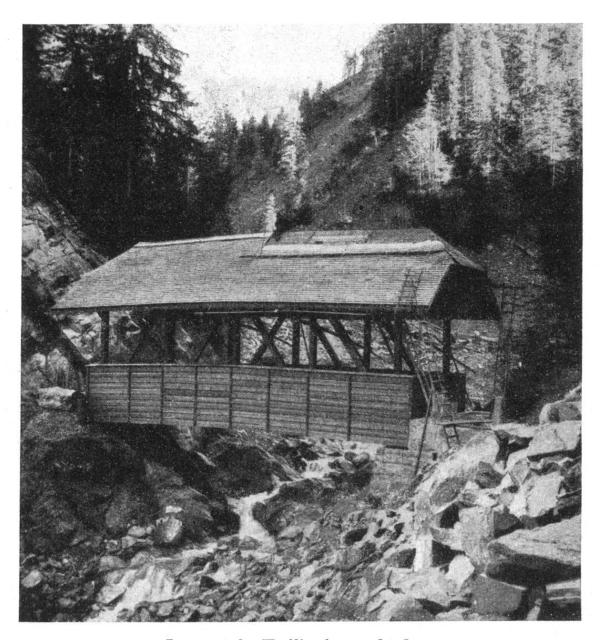
Le pont du Hœllbach, vu de flanc. Le tavillonneur est en train d'achever la couverture du toit.
