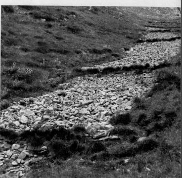
Fig. 4. Phot. E. Hess, Berne Enherbement de pentes d'éboulis, après la construction de petits ouvrages transversaux et mise en réserve du territoire en cause.
