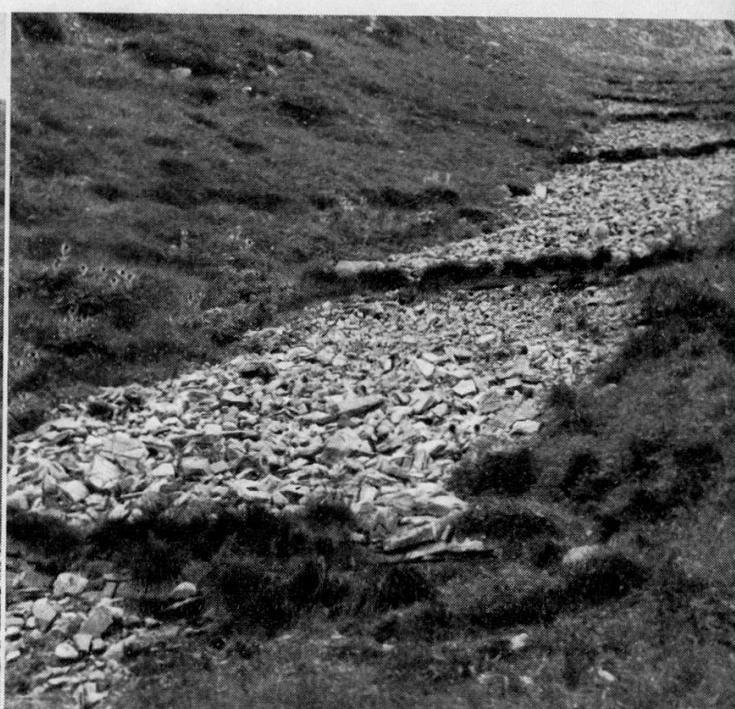
Fig. 4. Enherbement de pentes d'éboulis, après la construction de petits ouvrages transversaux et mise en réserve du territoire en cause.
