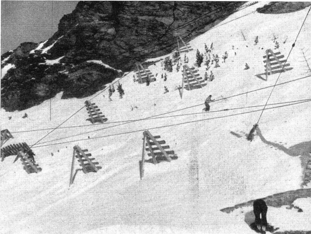
Fig. 3. Alp Grüm (Grisons). Pente garnie d'ouvrages de défense contre les avalanches, d'un type nouveau. A gauche : 4 panneaux placés en ligne sont tenus par un câble ancré dans le rocher. — A droite : „chevalets.“
