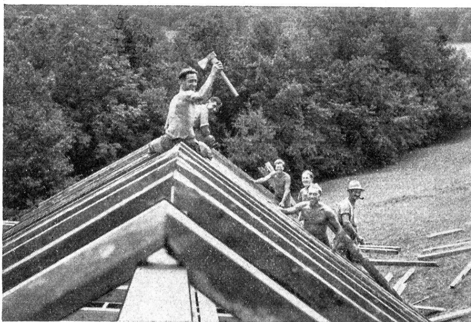
Construction, par un camp de travailleurs volontaires, d'un baraquement (à Niederweningen).
