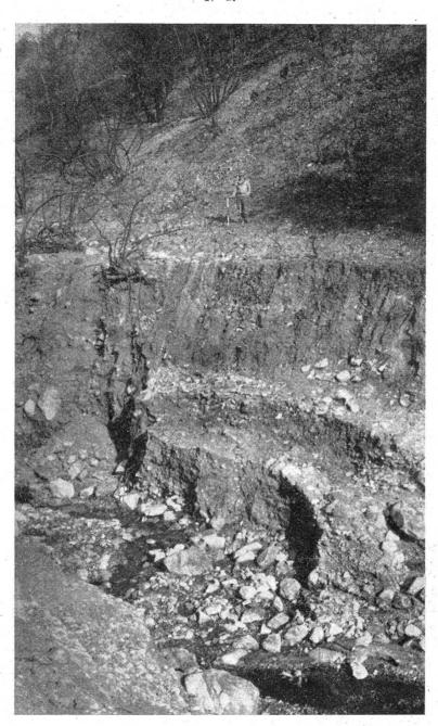
Même endroit qu'à la photo N° 1. Le barrage artificiel a été détruit par le torrent; le lit de ce dernier s'est approfondi.
