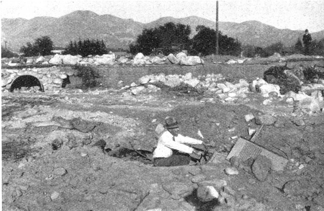
Matériaux déposés par le torrent sur la route et ses abords. A l'arrière-plan: montagnes dénudées par l'incendie.
