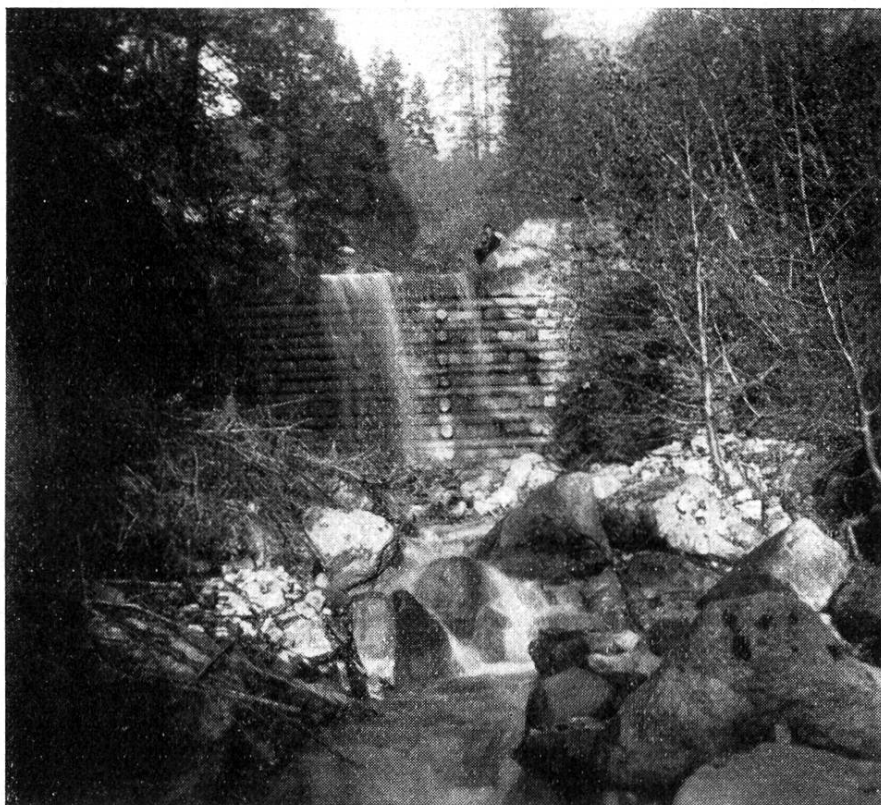
Vue d'un des barrages.
