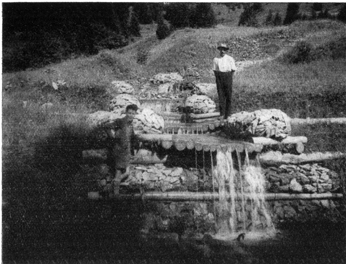
Barrage double avec cuvette en bois ronds. Phot. A. Remy, à Bulle.
