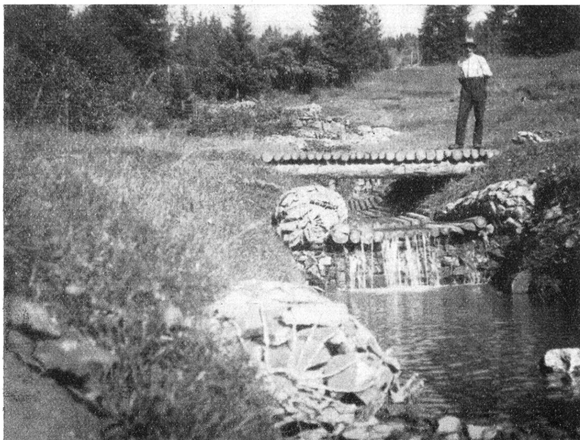
Phot. A. Remy, à Bulle. Barrage et ponceau. La partie à l'aval du barrage est non colmatée.
