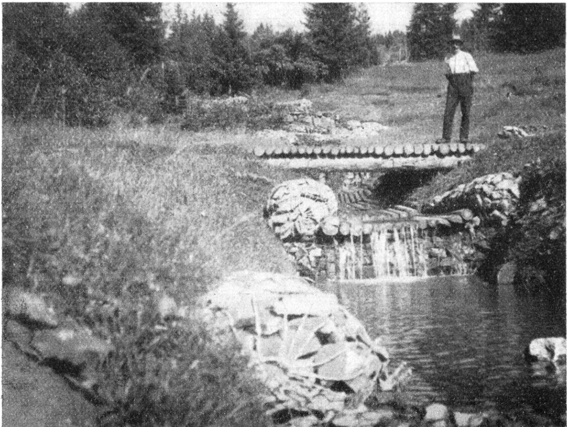
Barrage et ponceau. La partie à l'aval du barrage est non colmatée. Phot. A. Remy, à Bulle.
