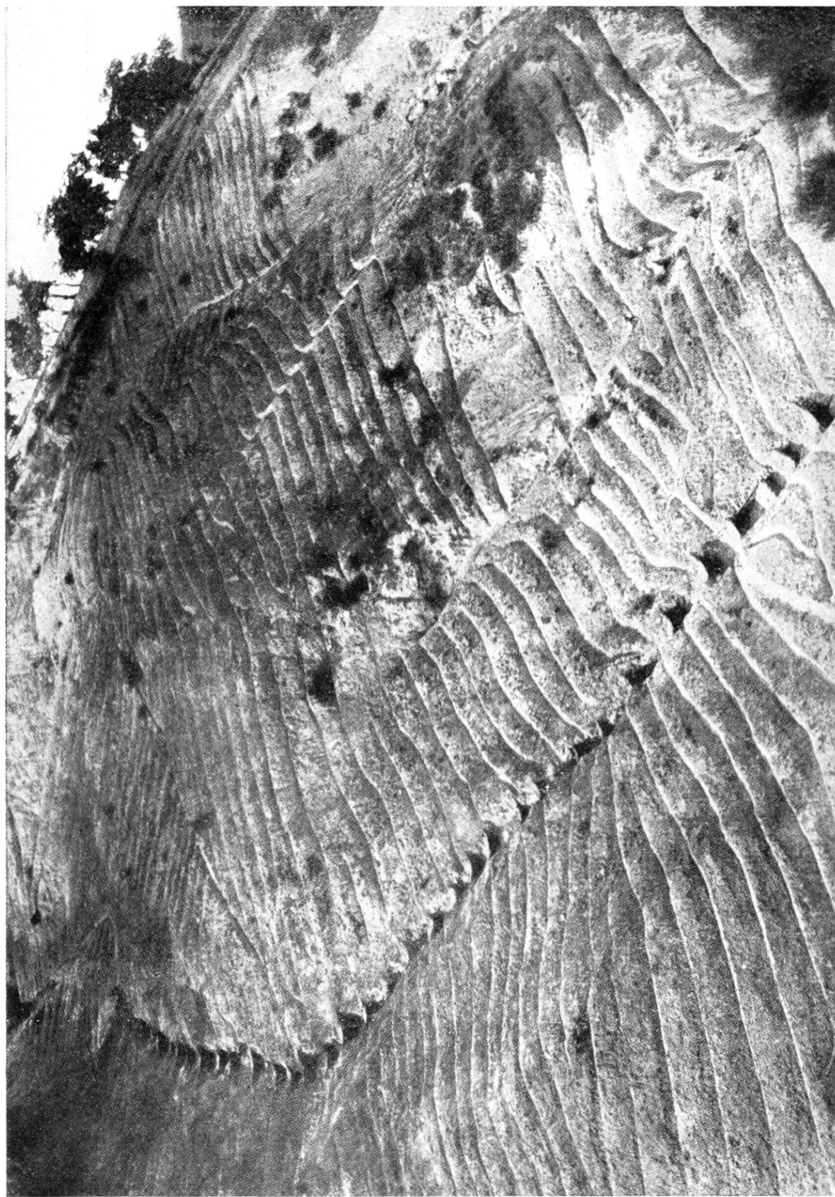
TYPE DE DRAINAGE ET CONSOLIDATION DU SOL AU MOYEN DE FOSSES HORIZONTAUX. Le lit du canal d'écoulement est pourvu de nombreux barrages rustiques. — Travaux exécutés par la milice forestière italienne, en l'an IX (légion VII, centurie de Benevento).
