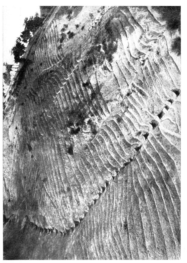
Le lit du canal d'écoulement est pourvu de nombreux barrages rustiques. — Travaux exécutés par la milice forestière italienne, en l'an IX (légion VII, centurie de Benevento). Type de drainage et consolidation du sol au moyen de fossés horizontaux.
