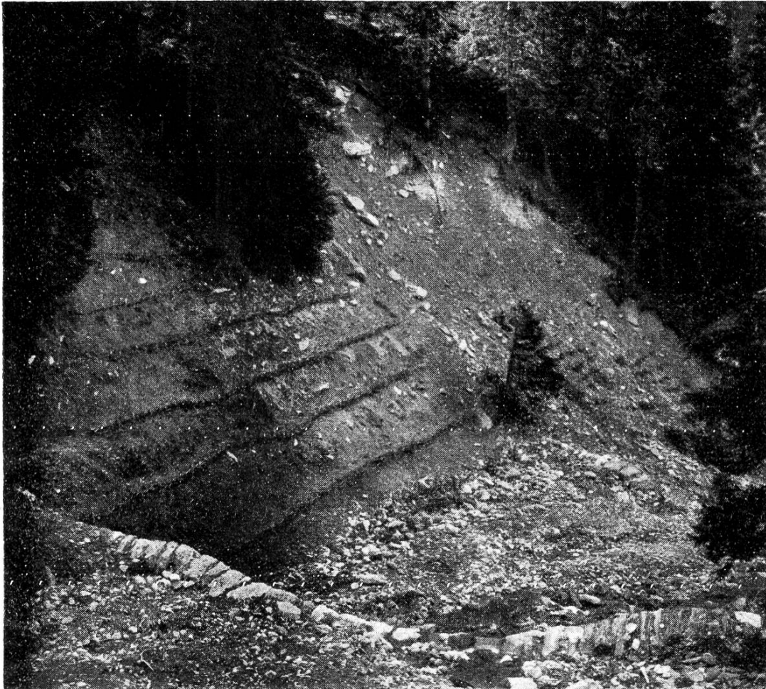
Torrent du Charmaix. Phot. Messines, Chambéry. Ravin d'Arron laz. Clayonnages et, au second plan, éboulements (1926).
