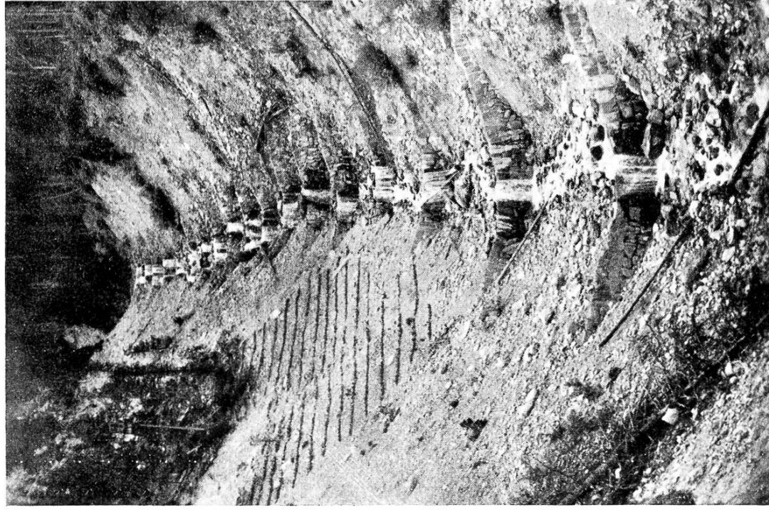
Phot. F. Fankhauser, Kehrsatz. TORRENT DU CHARMAIX, EN SAVOIE. a) Ravin d'Arrondaz. Série de barrages et de clayonnages (1931)
