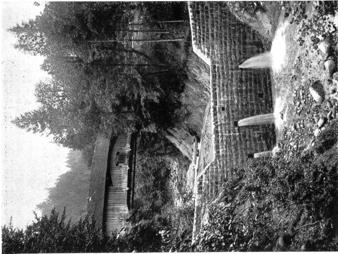
TRAVAUX DE DÉFENSE LE LONG DU RENGGBACH Barrage en maçonnerie ordinaire (n° 1), dans la partie inférieure de la gorge
