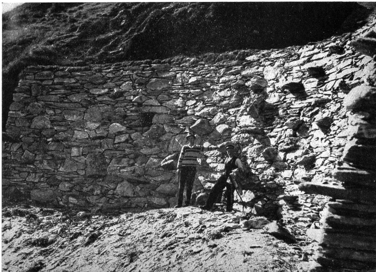
TRAVAUX DE DÉFENSE DE FALDUM MUR CURVILIGNE, AU SCHÖNBÜHL, DANS UNE DÉPRESSION DU TERRAIN Mauvais exemple
