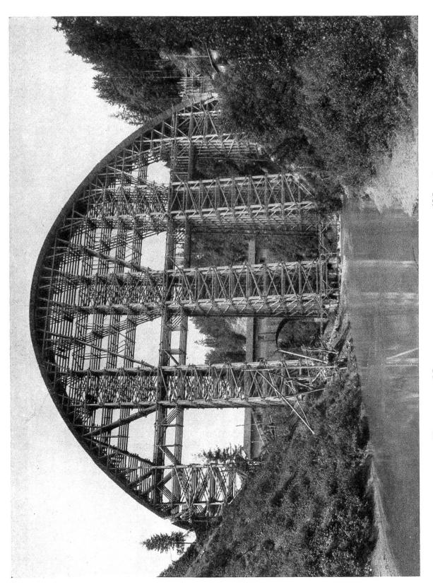
PONT DE HUNDWIL SUR LE RUISSEAU D'URNÄSCH Echafaudage de la voûte centrale, construit en 1924 (Constructeurs: Züblin & Cie, entrepreneurs, à Zurich)
