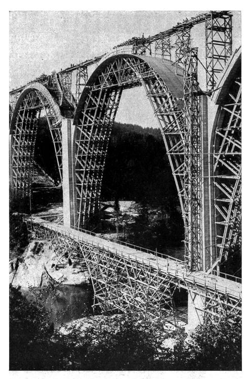
PONT DE PÉROLLES SUR LA SARINE, A FRIBOURG Echafaudage construit en 1920/22 (Constructeur: R. Coray, charpentier, à Coire)
