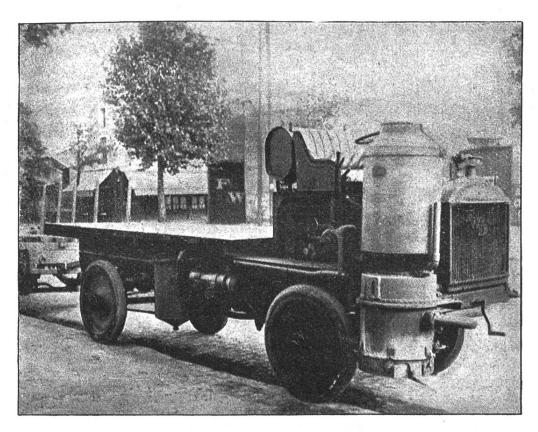
Fig. 7. Gazogène Malbay, sur 5 tonnes F. W. D.
