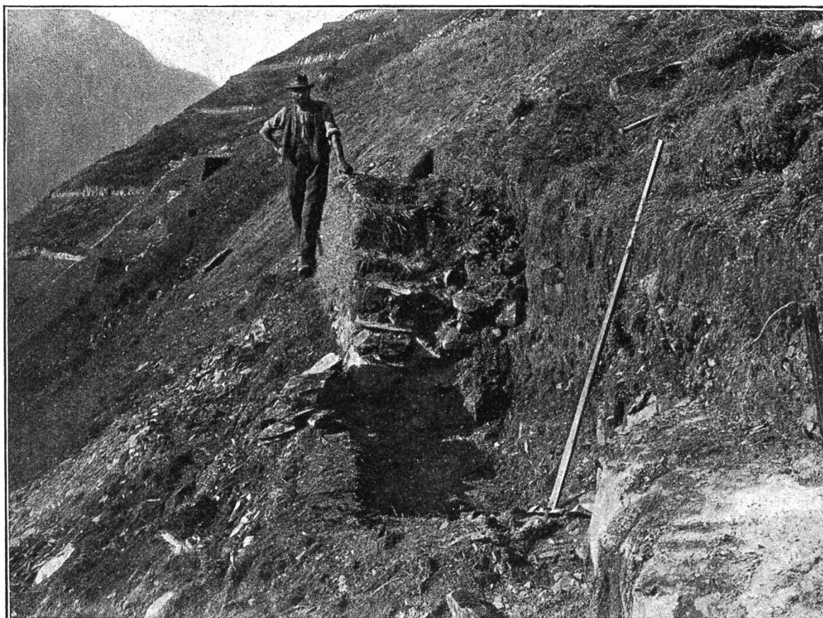
Fig. 1. La Meissenplanke, près d'Elm. Une terrasse combinée en construction.
