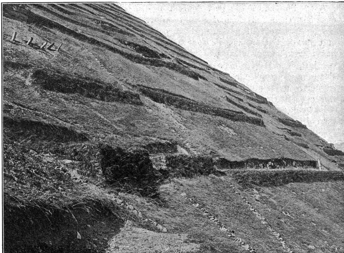
Fig. 2. A la Meissenplanke près d'Elm. Terrasses combinées avec, au premier plan, des couliresses de drainage.
