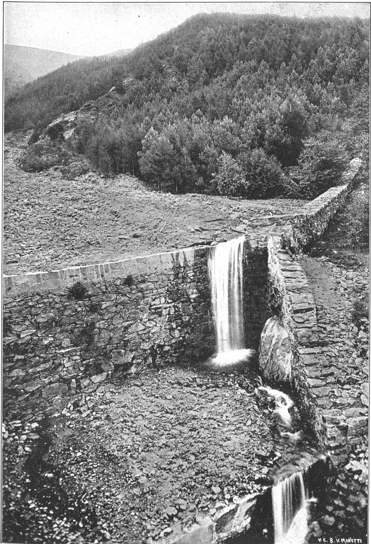
Bassin supérieur du Cassarate, Val Colla. Barrages et reboisements (mélèzes et pins) Pietrarossa, Colla.
