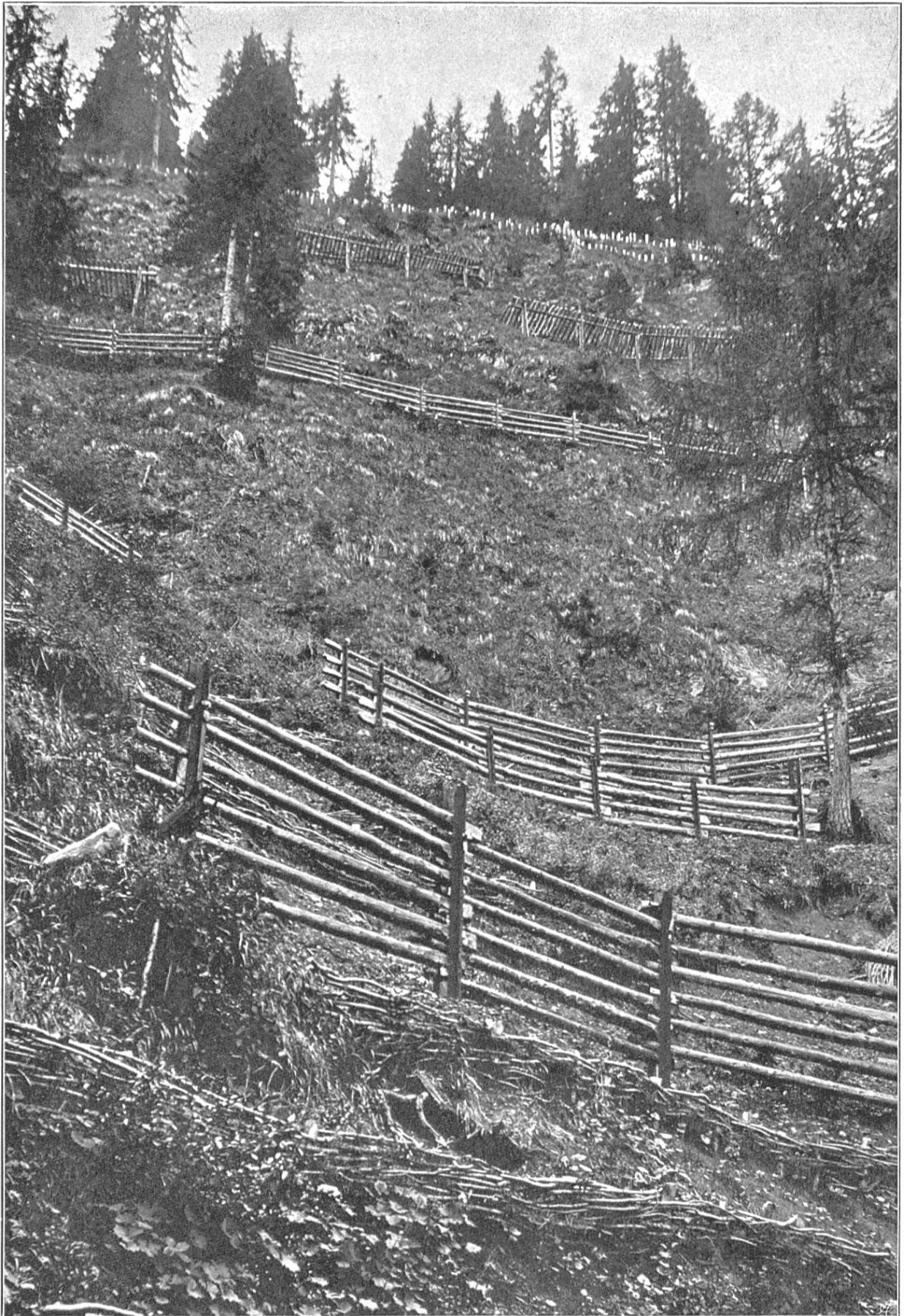
Parois protectrices et ponts à neige, élevés dans le couloir sud de l'avalanche de Calcestri près de Piotta.
