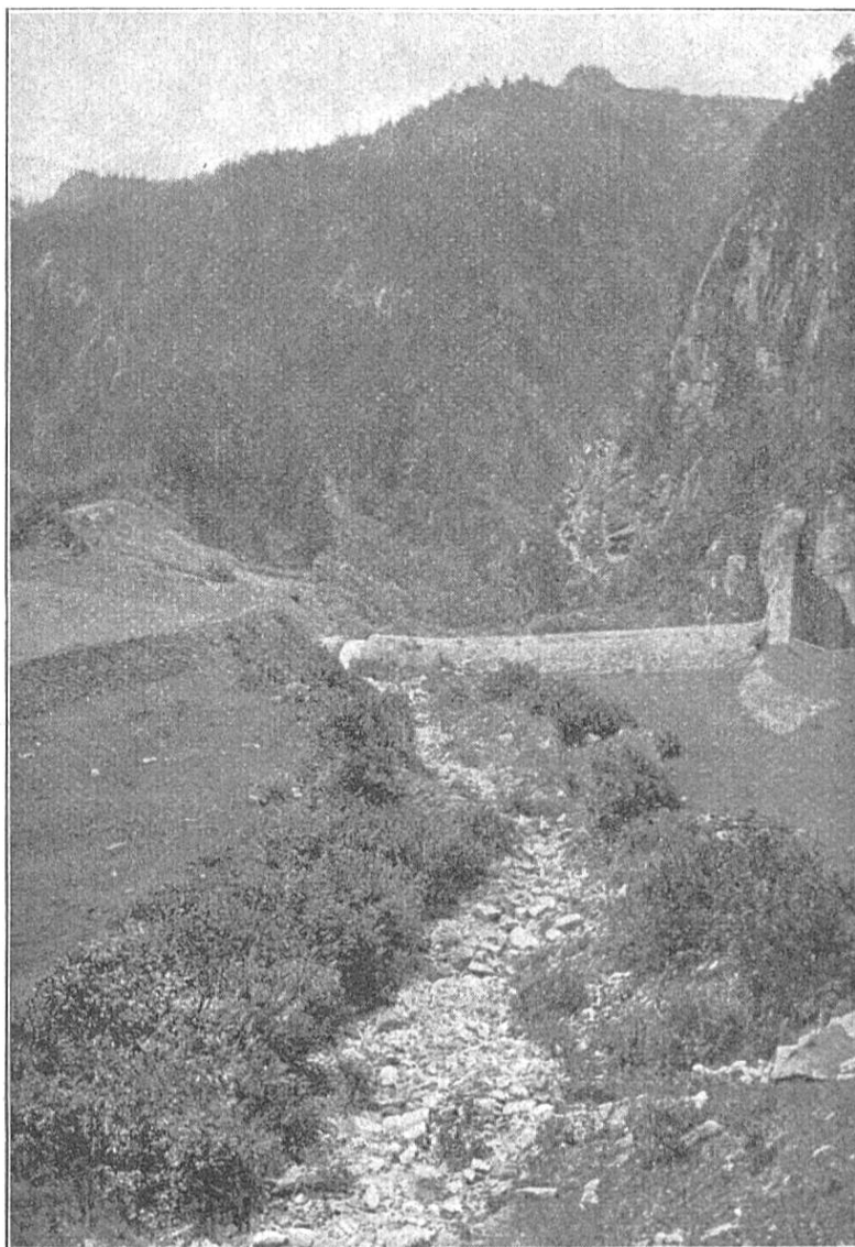
Fig. 3. Galerie contre l'avalanche de l'Entschigtal, section supérieure, au-dessous de Wassen, km 66'070—66'170.
