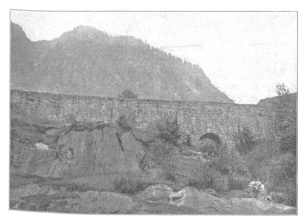
Fig. 5. Mur de protection contre l'avalanche de l'Entschigtal, section inférieure de la ligne, près de Wassen, km 60'150—60'200.
