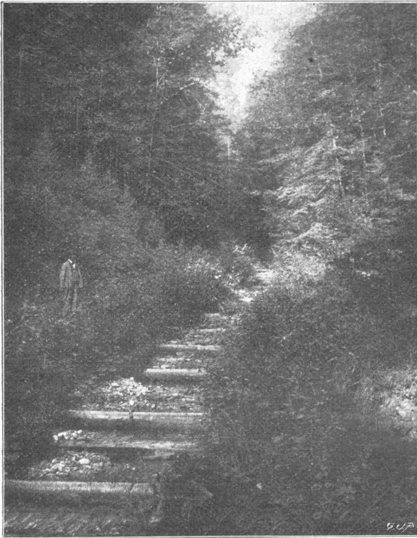
Correction du Niedermattgraben.
