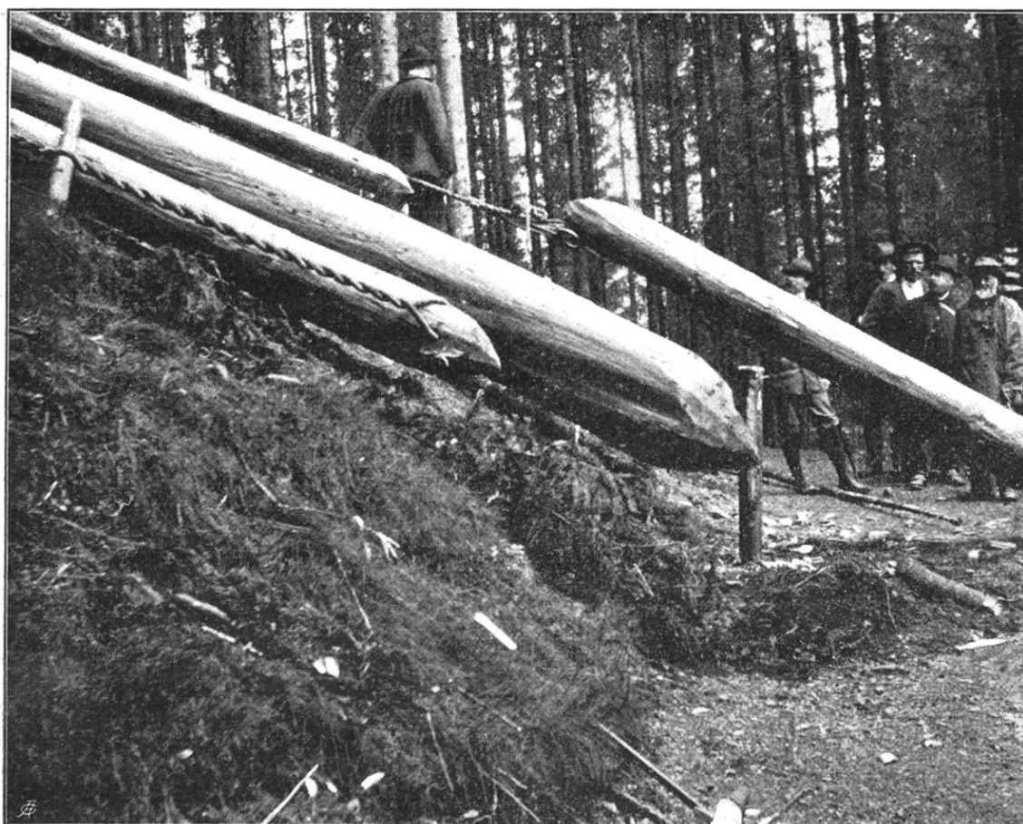
Construction d'une riese.
