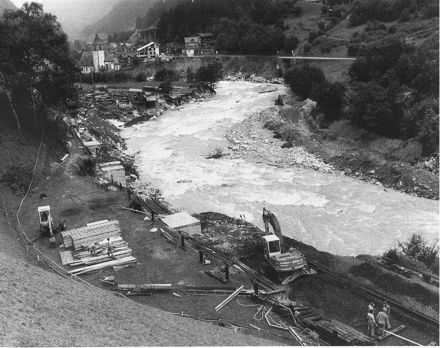
53 Oberhalb der Kirche Gurtinnen/Wiler (hinten) baute man nach dem Unwetter eine Hilfsbrücke mit vier Zwischenpfeilern (unser Bild, im Reussbett sind die restlichen alten Gleisstücke zu sehen). Die errichtete Hilfsbrücke wurde später demontiert, nachdem ein neuer Damm aufgeschüttet worden war, der Widerlager und Pfeiler zudeckt
