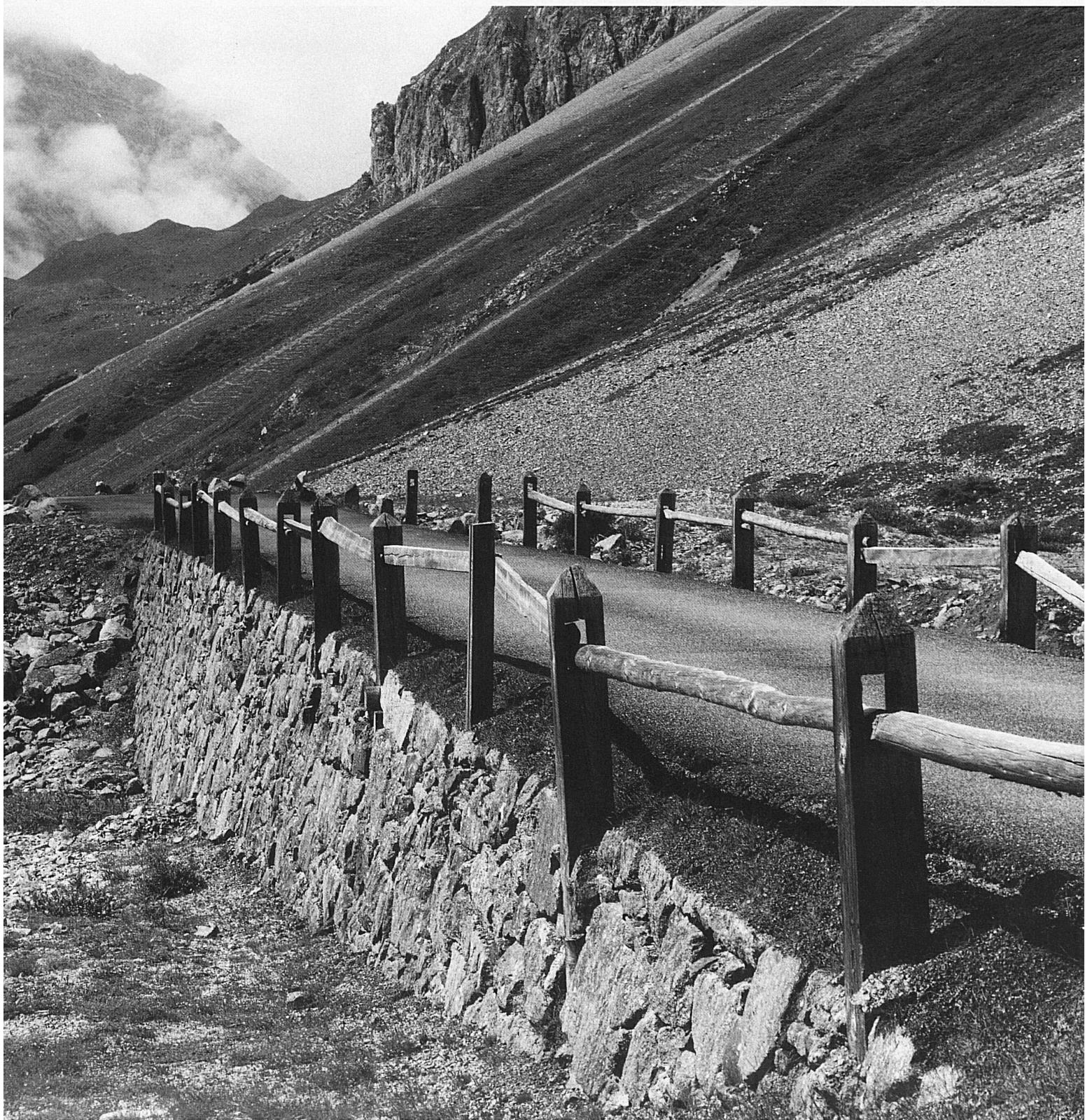
Dammkonstruktionen im Val digl Diavel: Ein prägendes Element der Kunststrassen des 19. Jahrhunderts sind die ganz ohne Zement oder Mörtel aufgeschichteten Bruchsteinmauern. Ebenso wie die Holzpfosten (1) sind auch die Randsteine (5) im Mauerwerk ohne Bindemittel verankert. Allerdings ist der abgebildete Damm (4) kürzlich überschüttet und verbreitert worden, ohne auf die historische Bausubstanz Rücksicht zu nehmen
