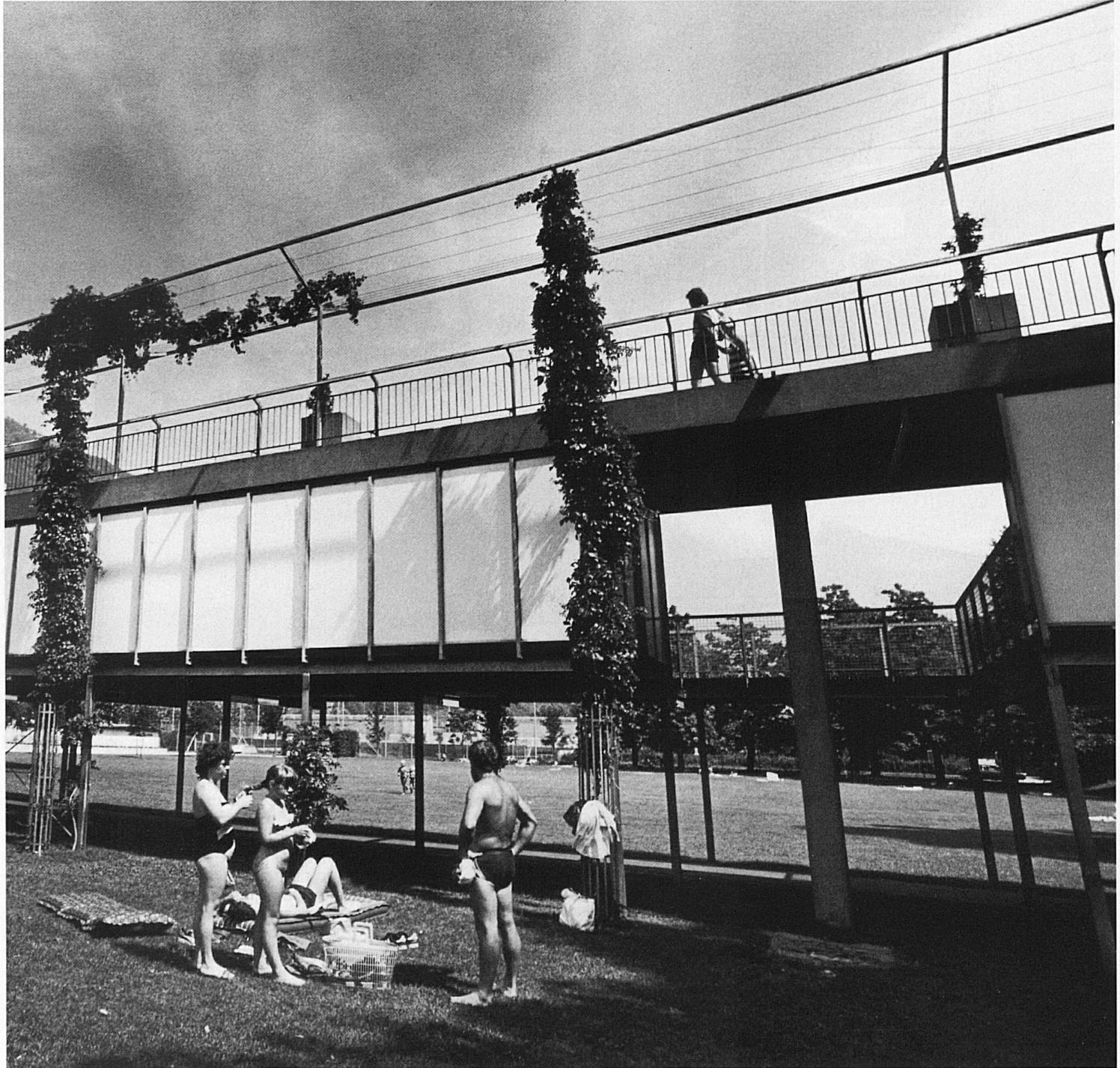
34 Die 1967–70 von den Architekten Aurelio Galfetti, Flora Ruchat-Roncati und Ivo Trümpy erbaute Badeanlage besteht aus zwei selbständigen Systemen, die ineinander greifen, das eine aus Beton, das andere aus Stahl. Darunter entstand ein schattiger Fussweg
