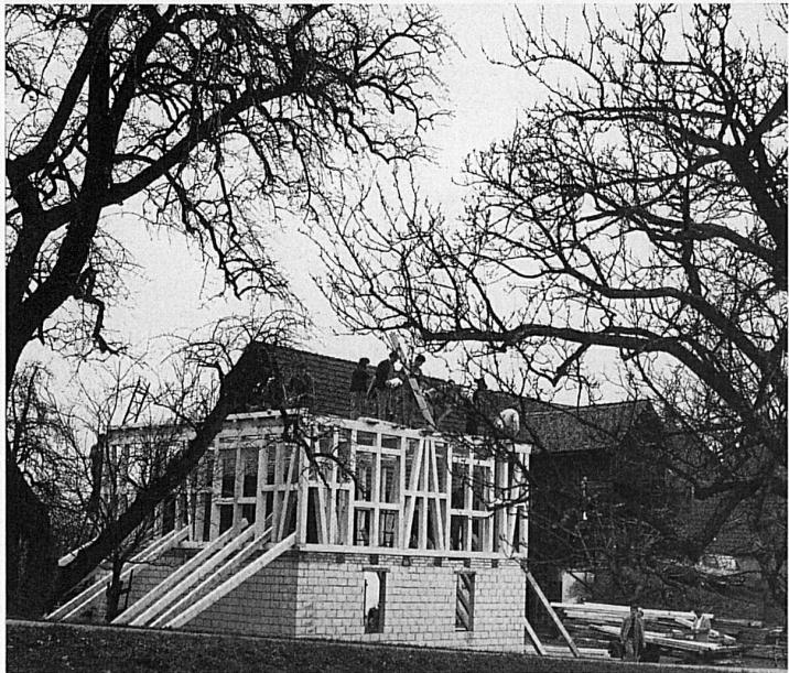
9 Auf der Baustelle misst der Zimmermann zuerst den Unterbau des Hauses aus – die inzwischen zum Bauplatz transportierten Hölzer müssen zentimetergenau passen. Als Basis für den gesamten Wandaufbau legt er daraufhin die Schwelle. Rund um das Gebäude stehen, nach Wand und Position sortiert, die weiteren Elemente der Konstruktion.
