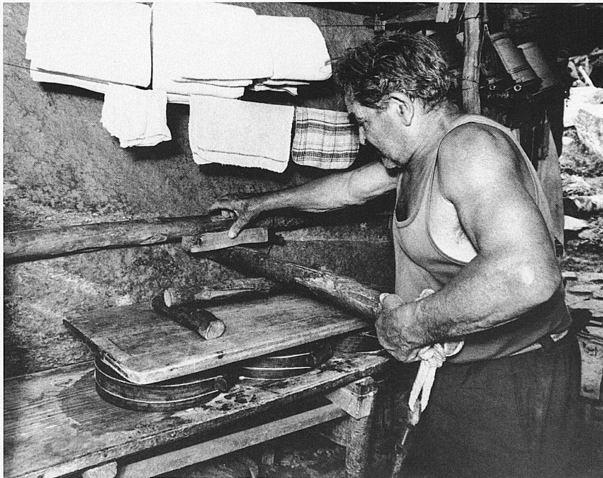
La massa viene tolta dalla caldaia con un panno, posta in una forma di legno (37) e pressata (38).
