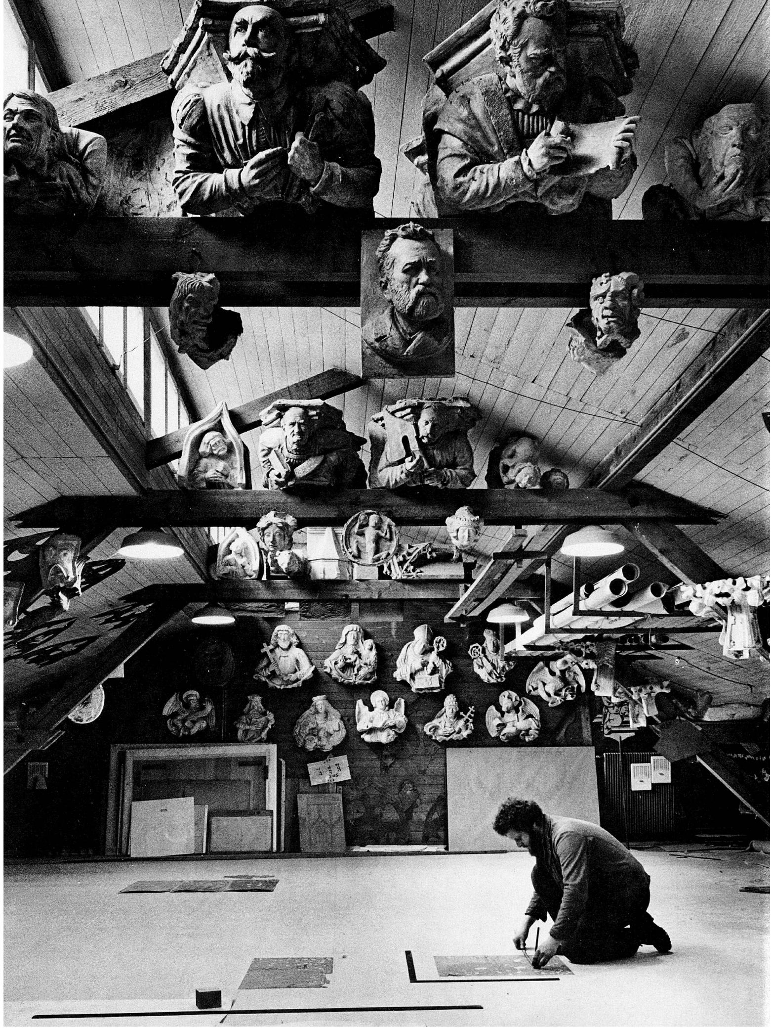
63 Der Reissboden in der Bauhütte. Hier werden die am Bau vermessenen Architekturteile am Boden im Massstab 1 : 1 aufgezeichnet, danach Schablonen aus Plastik oder Zinkblech angefertigt, die der Übertragung auf den Stein dienen. Unter dem Dach erkennt man Gipsabgüsse von Kragsteinen mit den Bildnissen von Bauleuten, die in den 1890er Jahren am Helmaufbau beteiligt waren. Im Hintergrund Abgüsse von Schlusssteinen im Chorgewölbe.
