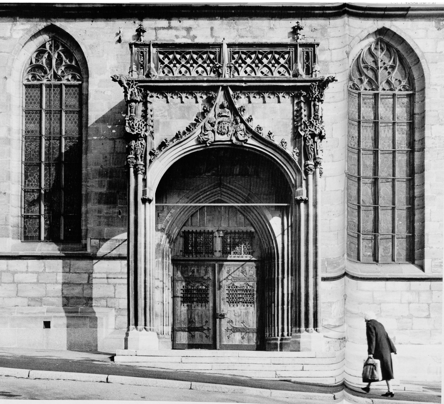
Südportal der Heilig-Kreuz-Kirche, der Hauptkirche Rottweils. Der gotische Bau mit dreischiffigem Langhaus und Netzgewölben entstand im 15. Jahrhundert durch Umbau einer romantischen Vorgängerkirche. Im Innern zugekaufte wertvolle gotische Altäre
