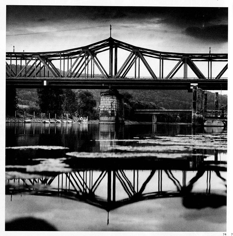
74 Pour le pont à voie unique, construit en 1927/28 sur le canal de l'Aar près de Brügg, sur le trajet de Berne à Bienne, on a utilisé de l'acier siliceux de haute qualité. Son envergure est de 2× 55 m. Pour la double voie, on a construit en 1966 un second pont parallèle identique. 75 Par suite du déplacement du tronçon Ziegelbrücke–Weesen de la ligne Zurich–Coire, on a construit en 1969 le pont «Biberlikopf» au-dessus du canal
