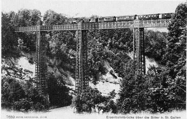
Il ponte di ferro costruito nel 1856 e smantellato nel 1926, che scavalcava la Sitter presso S. Gallo, costituiva un genere di costruzione nuovo in Europa: la trave reticolare lunga 164 m poggiava su pilastri di ghisa. Cartolina postale attorno al 1900
