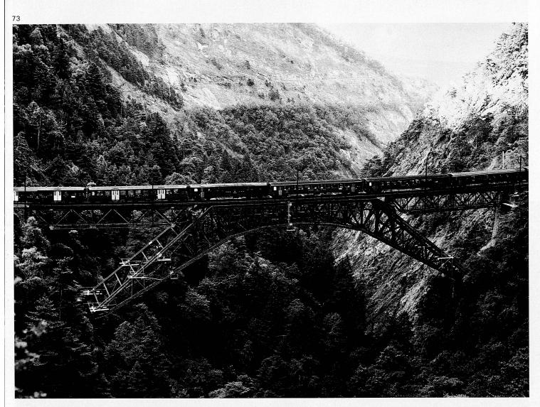
73 Die Bietschtalbrücke der BLS an der Lötschberg-Südrampe aus den Jahren 1910–1912 ist eine interessante Konstruktion mit zwei Vorbrücken. Sie überspannt 95 Meter und wiegt 985 Tonnen. Der Ausbau auf Doppelspur, der von Anfang vorgeplant war, ist zurzeit im Gange
