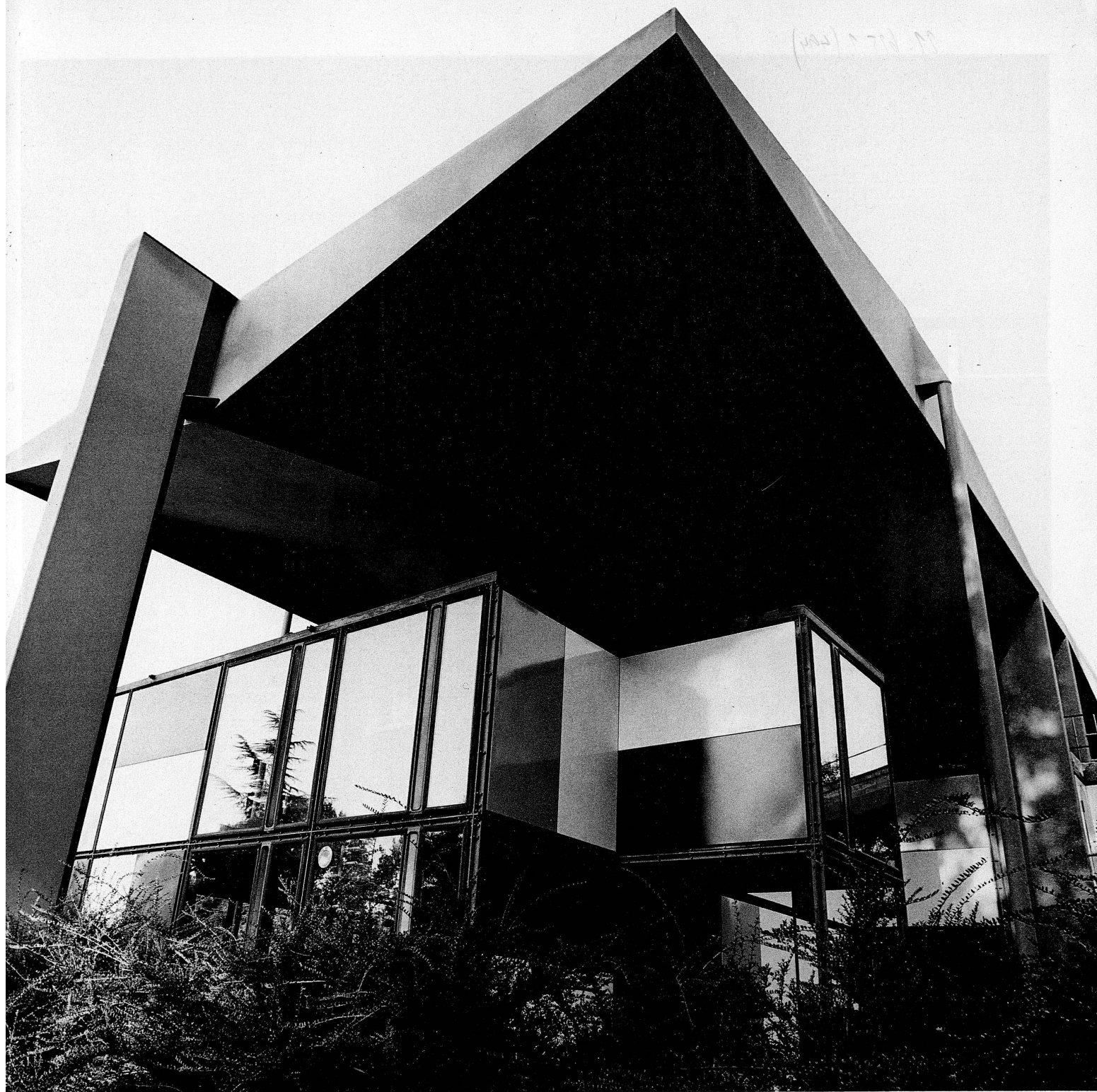
La Maison d'Homme, Centre Le Corbusier, Zürich, 1967; Architekt: Le Corbusier.
