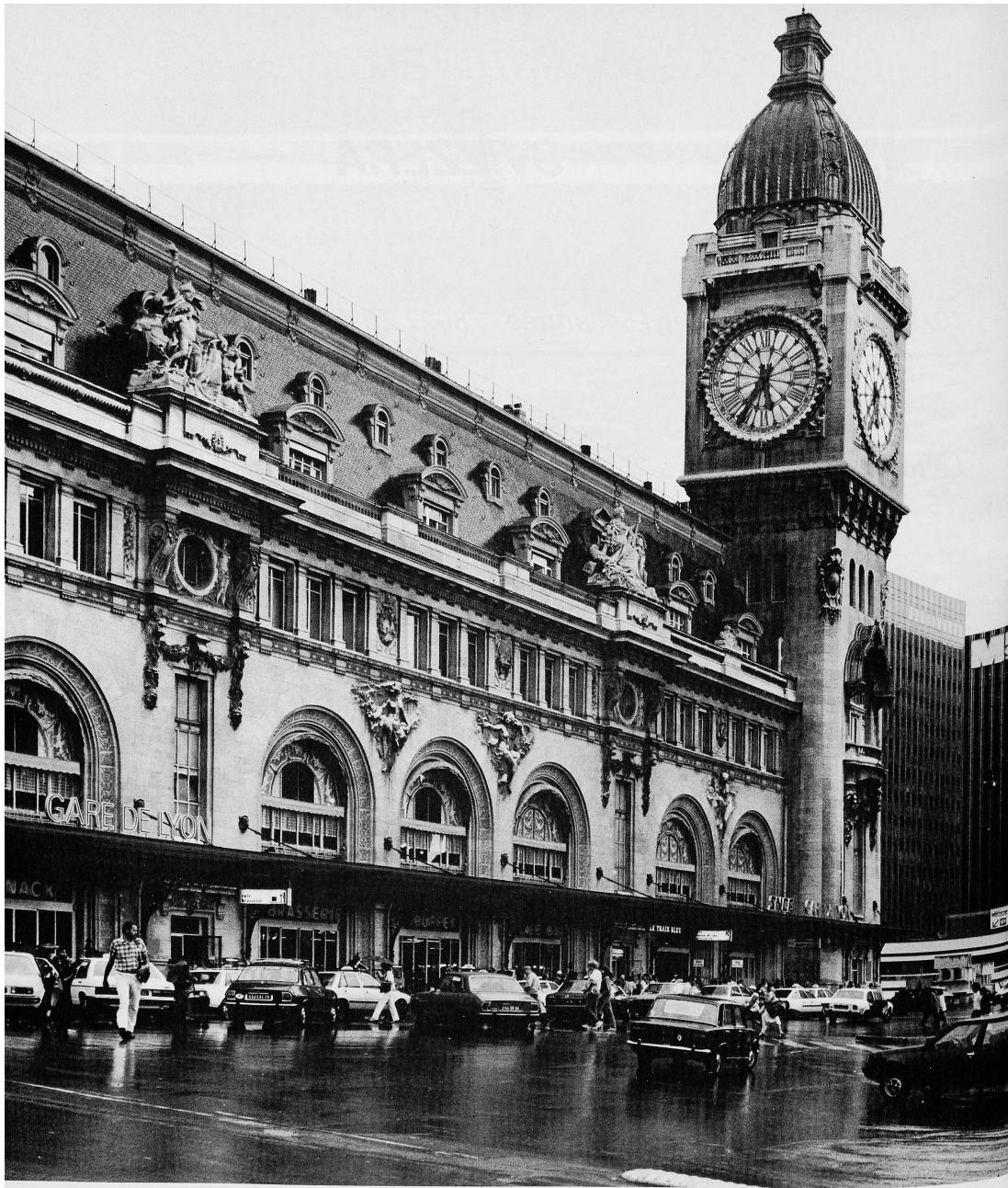
Die Gare de Lyon, einer der sechs grossen Kopfbahnhöfe von Paris, stammt aus der Zeit der Jahrhundertwende. Der für die Bahnhofsarchitektur des 19. Jahrhunderts charakteristische Uhrenturm, der sowohl funktionelle wie symbolische Bedeutung hatte und mit den alten städtischen Wahrzeichen, Kirchturm und Stadttor, wetteiferte, spiegelt sich heute in den Glasfassaden der Hochhäuser, die ringsum emporstreben
