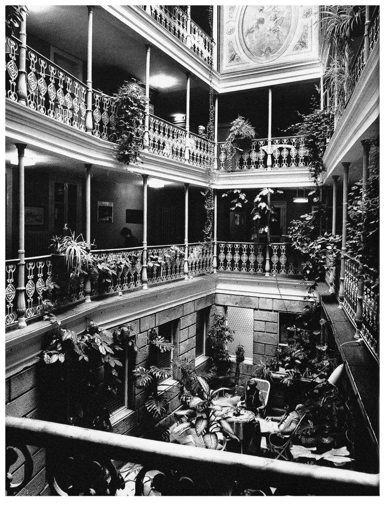
Zwischen dem spätmittelalterlich-barocken Alttrakt des Badehotels Zur Blume und seinem 1873 neu gebauten Hintertrakt wurde ein Säulenhof konstruiert (12). Stützen und Geländer der drei Galerien sind, dem Zeitgeschmack entsprechend, aus Gusseisen. Das Haus besass als erstes in Baden einen Personenaufzug. Die vornehme Atmosphäre des Speisesaals (13) von 1873 mit seinen Wandpilastern, einem Deckenfresko und festlichen Stuckgiebeln über den Türen ist durch sorgfältige Restaurierung gewahrt worden
