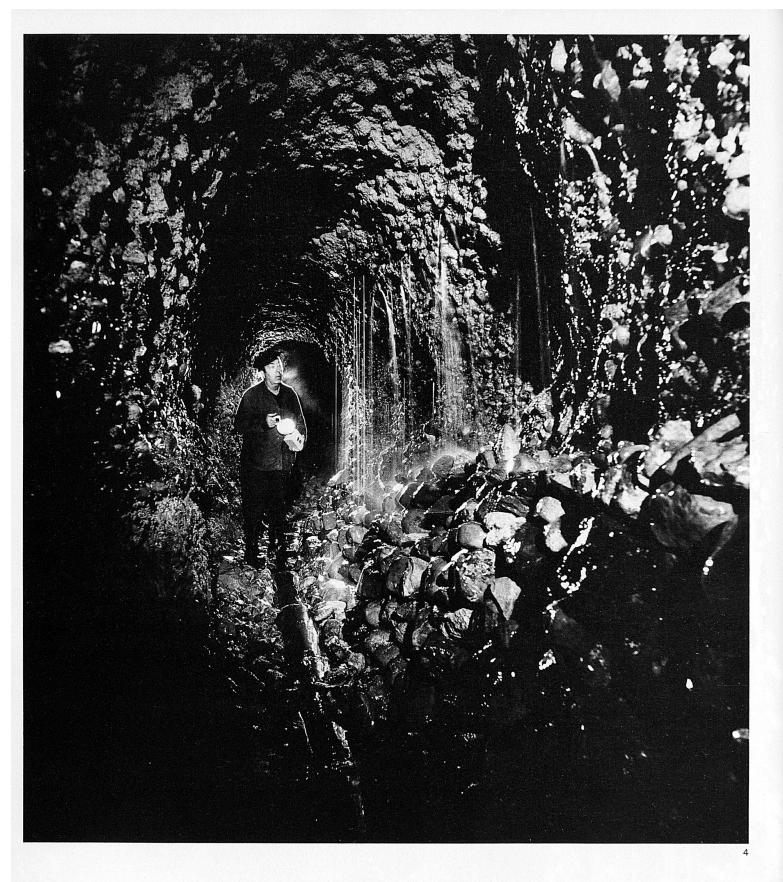
Quellwasser rinnt von den Wänden der 50 und 270 m in die Nagelfluh vorgetriebenen, begehbaren Stollen der Kohlbodenquelle und wird am Boden in Drainageröhren gefasst
