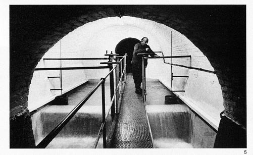
5 In diesem Gewölbe wird das Wasser aus den Stollen gesammelt – 4000 Liter pro Minute – und in die 6 km entfernte Zentrale in Sihlbrugg weitergeleitet. Hier wird es mit dem Wasser aus den Sihltalquellen vereint, gemessen und aufbereitet, dann fliesst es durch eine 18 km lange Rohrleitung von 55 cm Durchmesser nach Zürich.
