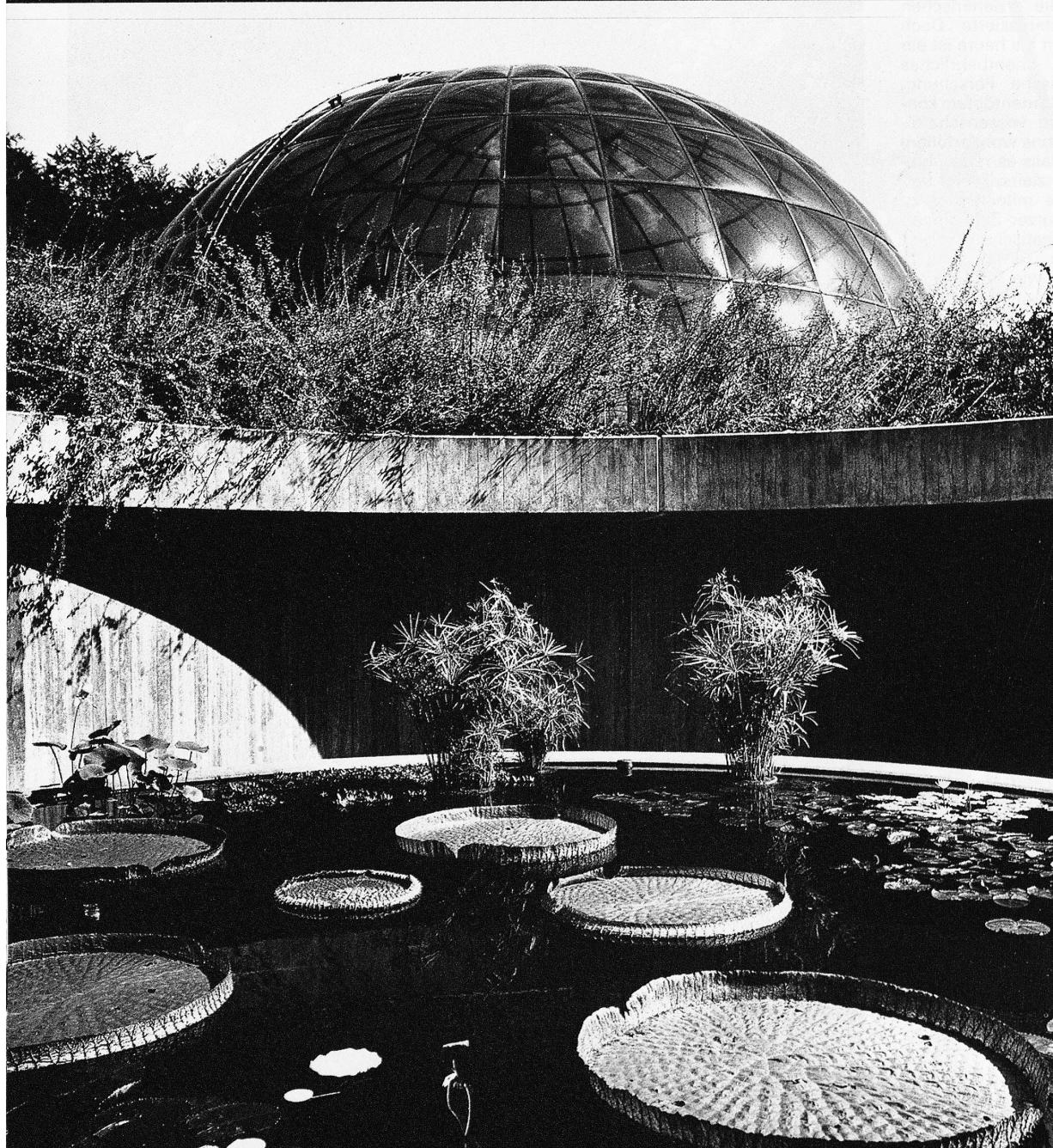
4 I tre nuovi padiglioni a cupola, di nuova concezione, coprono una superficie di 1000 m<sup>2</sup>. La costruzione, progettata negli Stati Uniti, è caratterizzata da uno scheletro di tubi in alluminio inossidabile che a sua volta sostiene il rivestimento di grandi lastre (fino a 7 m<sup>2</sup> per lastra) in fibra acrilica e plexiglas molto resistente alle intemperie.
