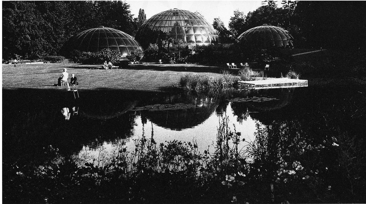
4 Die drei neuartigen kuppelförmigen Schauhäuser überdecken eine Fläche von gegen 1000 m<sup>2</sup>. Gekennzeichnet ist die in den USA entwickelte Konstruktion durch ein Gerippe aus nichtrostenden Aluminiumrohren, welches zugleich die widerstandsfähige, grossflächige Acryl-Plexi-Verglasung (bis 7 m<sup>2</sup> grosse Scheiben) trägt.
