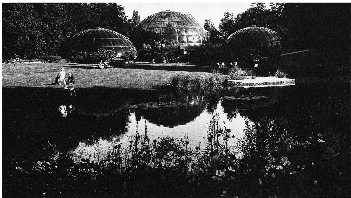
4 Die drei neuartigen kuppelförmigen Schauhäuser überdecken eine Fläche von gegen 1000 m<sup>2</sup>. Gekennzeichnet ist die in den USA entwickelte Konstruktion durch ein Gerippe aus nichtrostenden Aluminiumrohren, welches zugleich die widerstandsfähige, grossflächige Acryl-Plexi-Verglasung (bis 7 m<sup>2</sup> grosse Scheiben) trägt.
