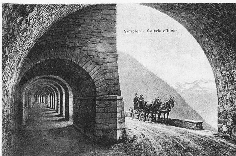
*Vecchie e nuove gallerie di protezione. Già sotto la direzione dell'ingegner Céard erano stati costruiti 525 m di gallerie allo scopo di proteggere la strada dalla caduta di sassi e dalle valanghe. Oggi, 6 km di gallerie e 1587 m di tunnel rendono viabile la strada anche d'inverno*
