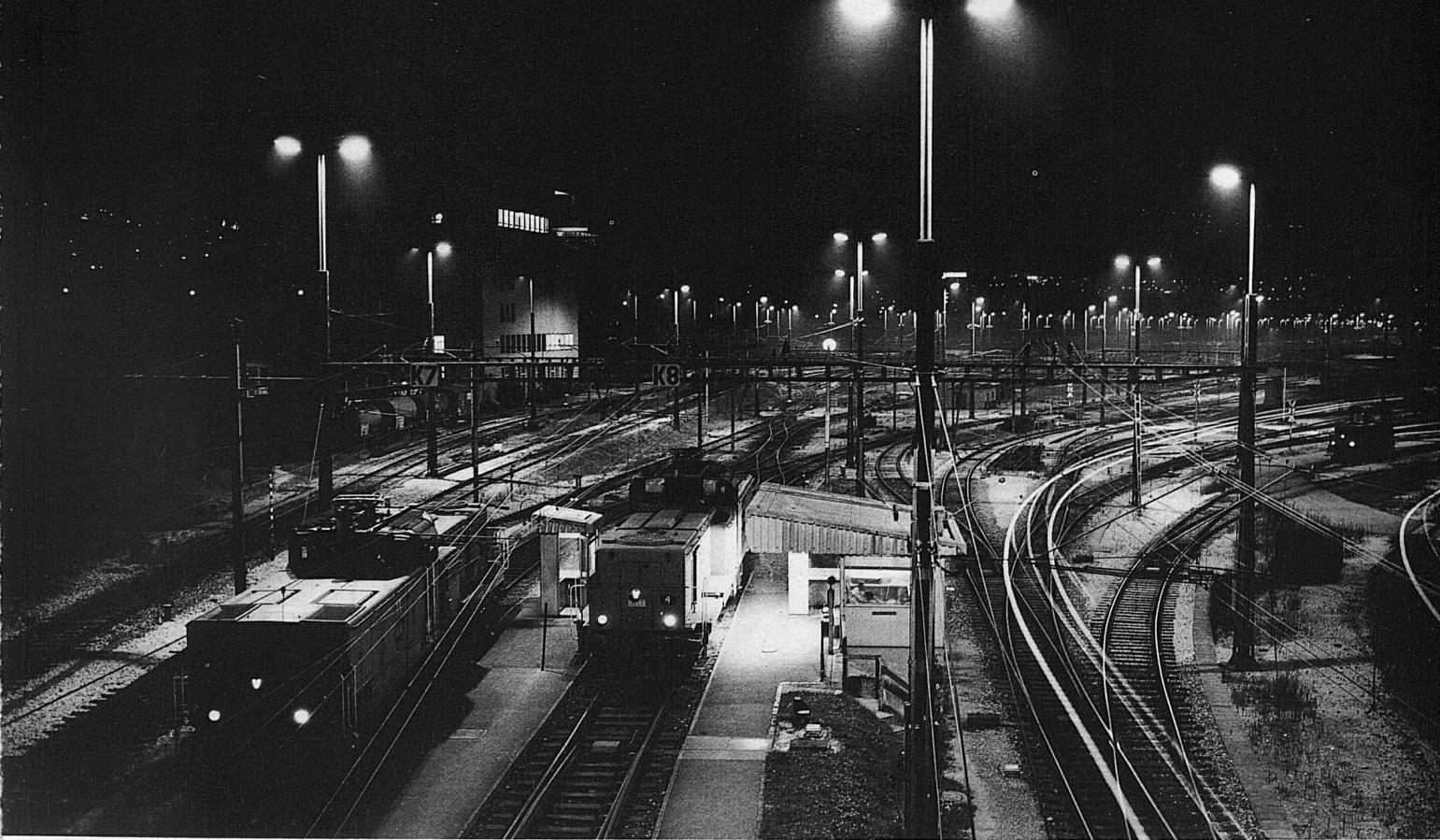
Der Rangierbahnhof von Chiasso am Südende der grossen Alpentransversale über den Gotthard. Über den Ablaufberg (im Vordergrund) rollen im Tagesdurchschnitt 2600 Güterwagen in die 19 Gleise der Richtungsgruppe. Aus diesen nach Richtungen geordneten Wagengruppen werden die Güterzüge nach Süden und Norden gebildet
