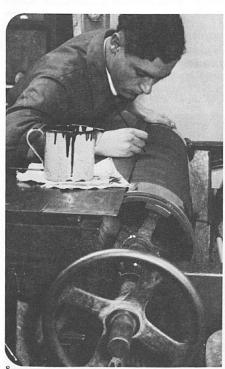
6,7,8 Das zu Beginn noch etwas geheimnisumwitterte Tiefdruckverfahren mit photographischer Übertragung und anschliessender Ätzung des Druckzylinders aus Kupfer
