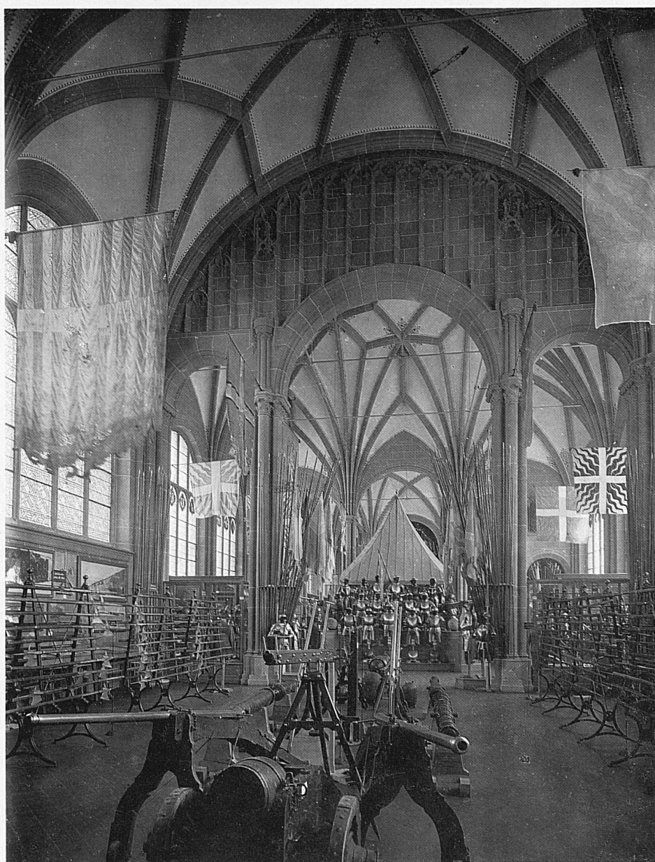
Smistamento dei pacchi presso la Posta centrale di Lucerna, costruita nel 1887. La volta è una combinazione di legno e di elementi di ferro
