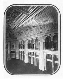
Architekten Ulrich und Müller. Die gewaltige stuckierte Decke wird von einem eisernen Dachstuhl getragen Salle du parquet de l'ancienne Bourse de Zurich à la Bahnhofstrasse, construite dans les années 1877 à 1880 par les architectes Ulrich et Müller. L'imposant
