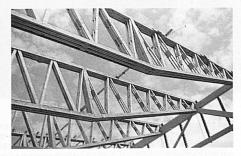
Hölzerne Fachwerkträger in Form eines «Fischbauches» für grossräumige Überdachungen. Photo Lignum · Poutres de bois en treillis en forme de «carcasse de poisson» pour toitures de grandes dimensions · Elementi a traliccio in legno, a forma di «ventre di pesce» per coperture di ampie aree Wooden lattice girders of fish-belly design for roofing large areas
