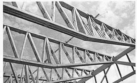
Hölzerne Fachwerkträger in Form eines «Fischbauches» für grossräumige Überdachungen. Photo Lignum · Poutres de bois en treillis en forme de «carcasse de poisson» pour toitures de grandes dimensions · Elementi a traliccio in legno, a forma di «ventre di pesce» per coperture di ampie aree · Wooden lattice girders of fish-belly design for roofing large areas
