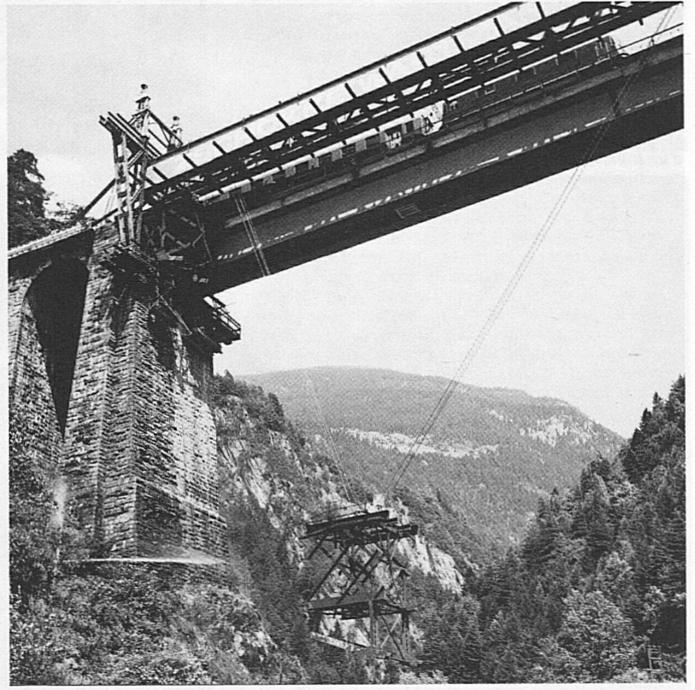
*Lavori di trasformazione del ponte sul Kerstelenbach, nel 1970. I tiranti di sospensione prefabbricati, alti 3 m, a superficie piena, sono stati fatti scorrere sulle vecchie armature reticolari che sono poi state smontate a fissazione conclusa. In seguito, i nuovi tiranti sono stati collocati nella loro posizione definitiva. Durante tutto il periodo dei lavori di trasformazione il traffico ferroviario si è svolto su un solo binario*
