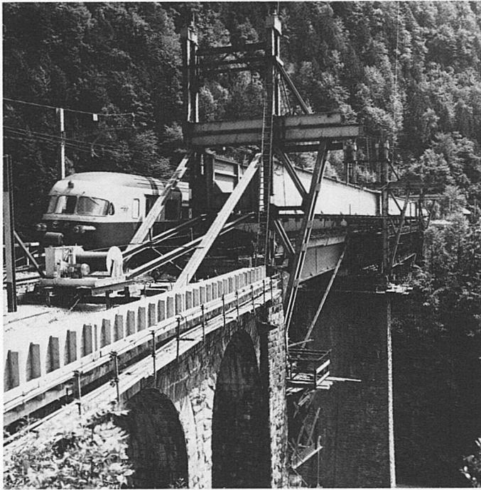
*Umbau der Kerstelenbachbrücke 1970. Die vorfabrizierten, 3 m hohen, vollwandigen Stahlträger werden über die alten Eisenfachwerkträger geschoben, diese daran aufgehängt und demontiert. Dann können die neuen Träger in ihre endgültige Lage abgesenkt werden. Während des ganzen Umbaus ging der Bahnbetrieb einspurig weiter. Photos SBB*
