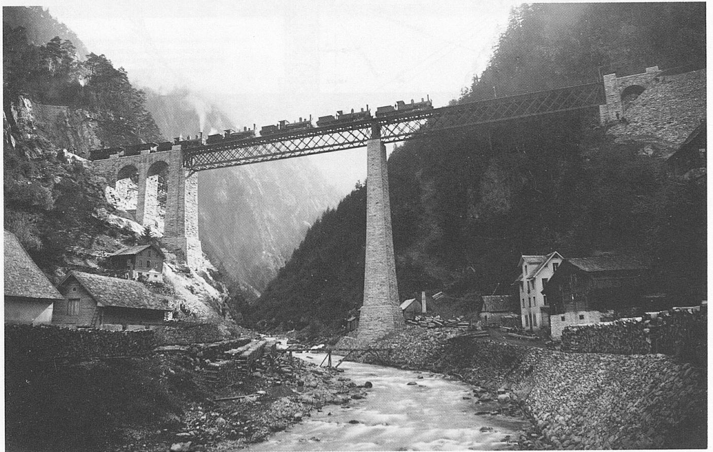
◀ Die Kerstelenbachbrücke 1880 im Bau und bei der Belastungsprobe. Zwei 50 m lange eiserne Fachwerkträger überbrückten das Tal vorerst einspurig in 50 m Höhe
