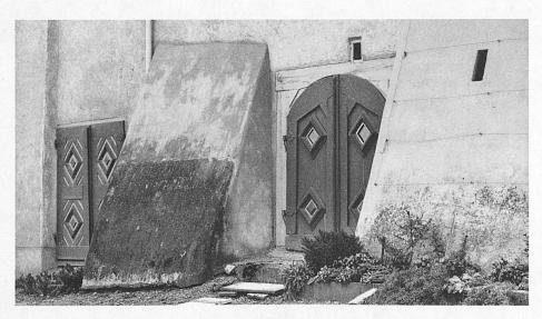
Die keilartige Verdickung der Hausmauer dient weniger der Stützung als der Kühlhaltung des Weinkellers
