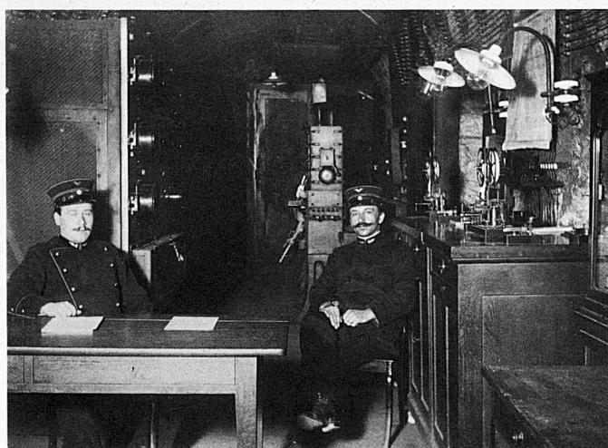
Der Simplontunnel besteht aus zwei annähernd 20 km langen Röhren, die in regelmässigen Abständen durch Querstollen verbunden sind. Ungefähr in der Mitte, 3000 m unter dem Monte Leone, befindet sich eine Tunnelstation, wo die Züge das Gleise wechseln können. Früher stellten Beamte von hier aus Weichen und Signale (Bild links, Photo SBB), heute läuft der Betrieb ferngesteuert. Oben: Blick von einer Tunnelröhre in die andere, wo eben ein Autozug vorüberfährt
