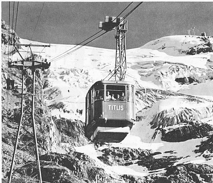
Bergbahnen Télécabliques Aerial cableways Engelberg–Trübsee–Stand–Titlis
