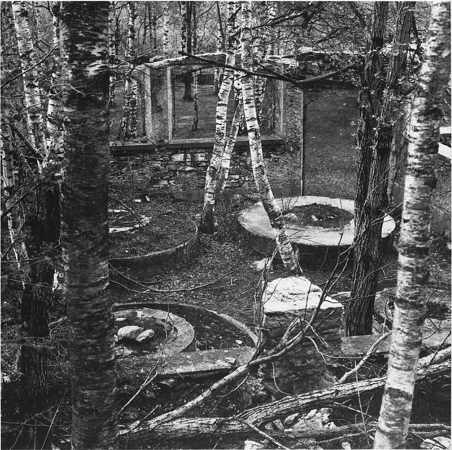
*Überreste der 14 Goldmühlen im Goldbergwerk Zwischbergen. Hier wurde das vom Pochwerk zerkleinerte Gestein zu Brei zermahlen und anschließend das Gold durch Amalgamierung mit Quecksilber ausgesondert*
