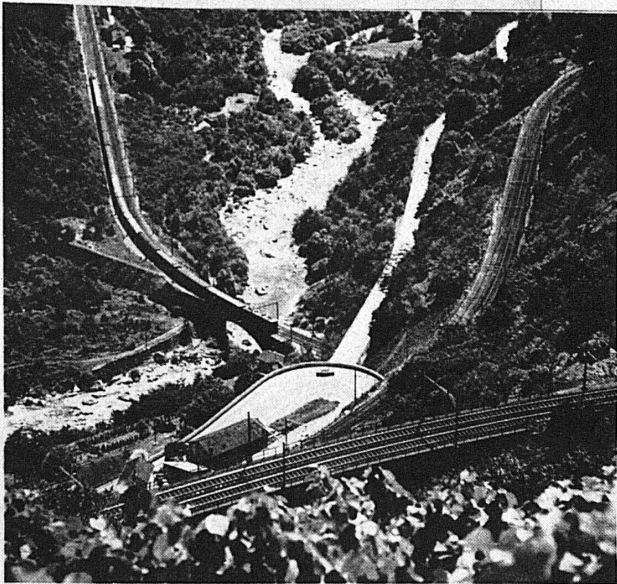
Panorama sur la Biäschina, près de Giornico : les tunnels hélicoïdaux de Pianotondo et de Travi se succèdent l'un après l'autre.
