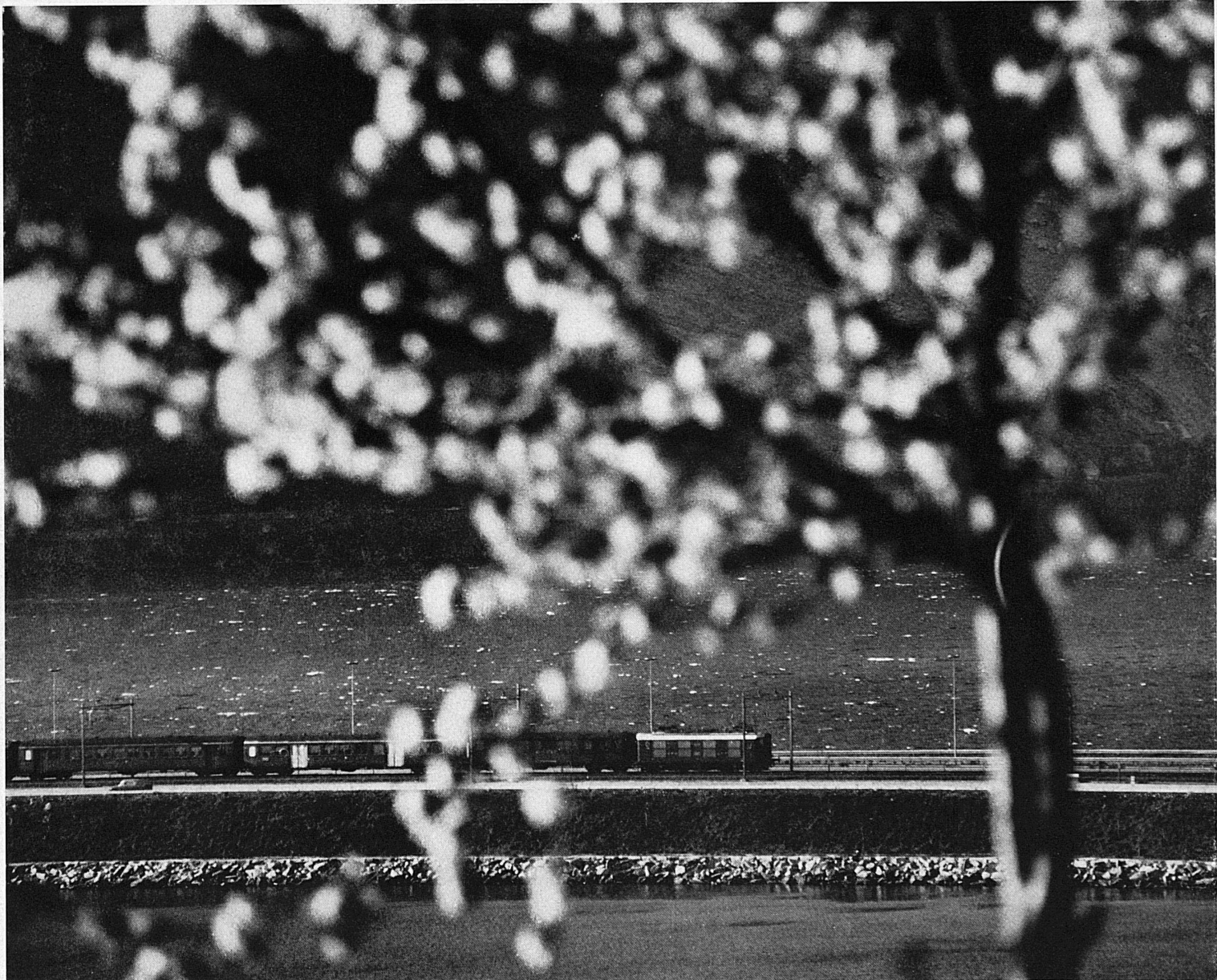
Zwischen Melide und Bissone überquert die Gotthardlinie auf einem Damm den Luganersee Entre Melide et Bissone, la ligne du Gothard traverse le lac de Lugano sur une digue Tra Melide e Bissone, la linea ferroviaria e la strada del S. Gottardo valicano il Ceresio su di una diga Between Melide and Bissone the Gotthard line crosses the Lake of Lugano on a dam
