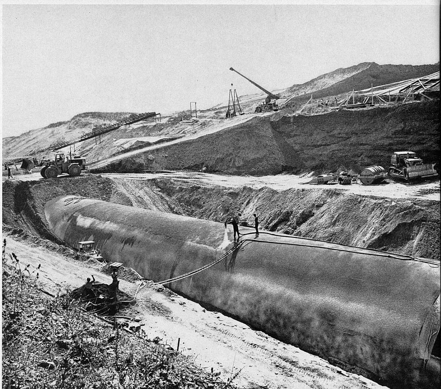
Das fertige Teilstück einer Betonröhre wird mit Spritzbeton versehen. Er schützt die darunterliegende, elastische Isolierhaut vor mechanischen Schäden, die beim Eindecken des Tunnels mit Aushubmaterial entstehen könnten. 300 000 m<sup>3</sup> Kies und Sand sind beidseitig der Baugruben breit ausgelagert
