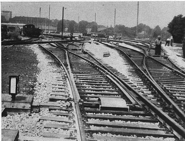
Ausbau Basel GB
