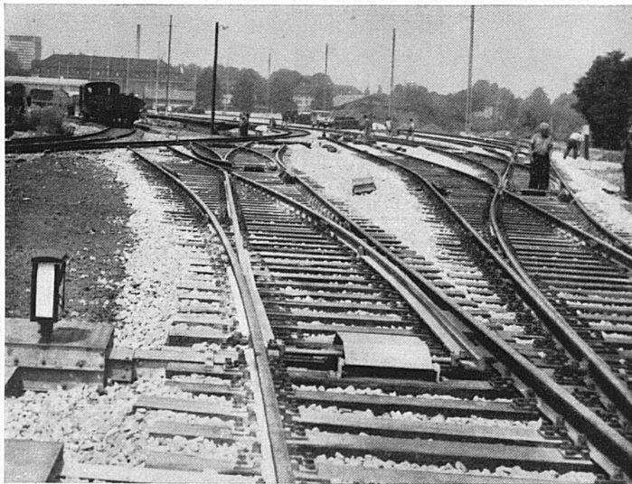
Ausbau Basel GB
