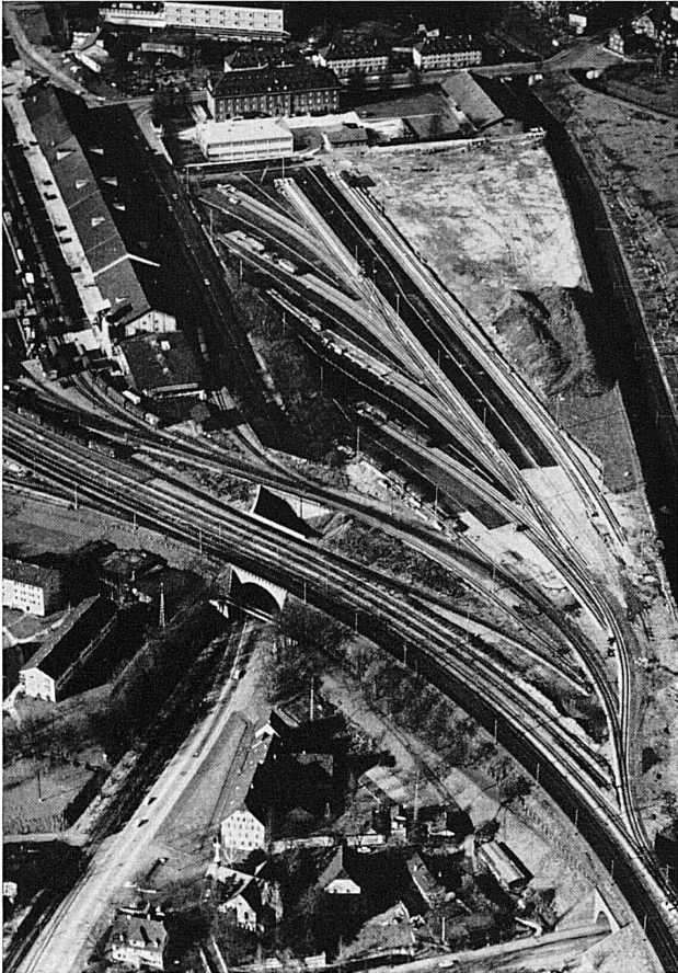
Ausbau Basel GB
