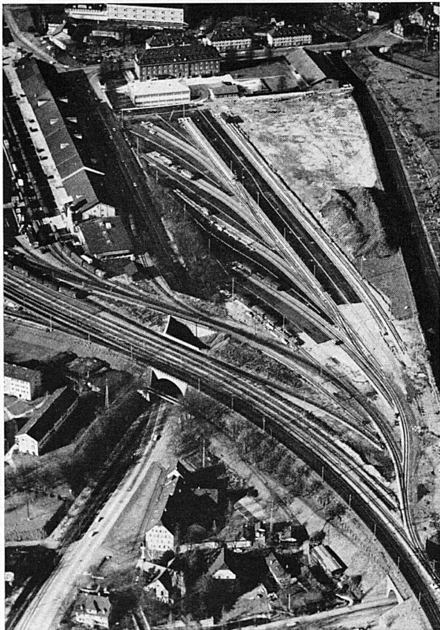
Ausbau Basel GB
