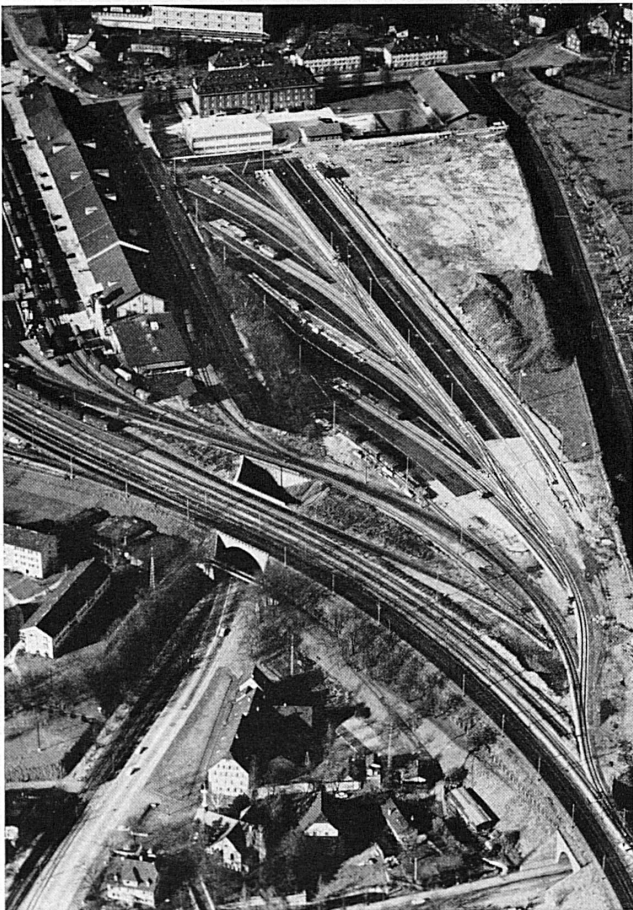
Ausbau Basel GB
